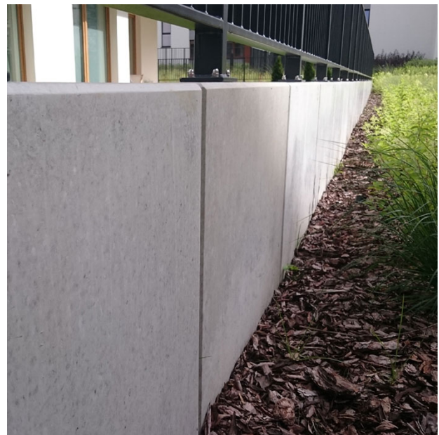
Mur oporowy z prefabrykatów L-kształtnych
